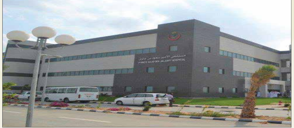
مشروع سفلة مستشفى الامير ابن جلوي بالاحساء وقد تم تنفيذه مع شركه الكفاح للمقاولات
