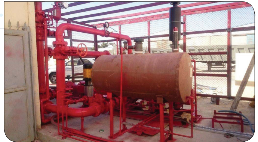
توريد وتركيب مضخات اطفاء حريق بالسلي المقاول: شركة ديارات.
